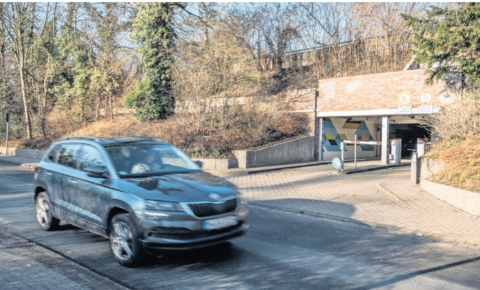
Auch die Tiefgarage des Celler AKH wurde früher als Schutzraum genutzt.
